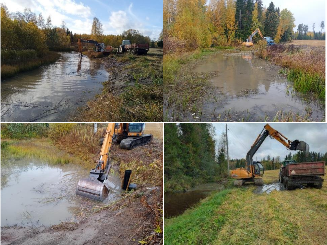
Kuva 4. Kunnostukset käynnissä Matjärven laskeutusaltailla, joista syksyllä 2022 kunnostettiin Ranta-Perttula ja Perttula (yläkuvat) sekä Järvenpää (alhaalla vasemmalla) ja syksyllä 2023 Savikko (alhaalla oikealla).
