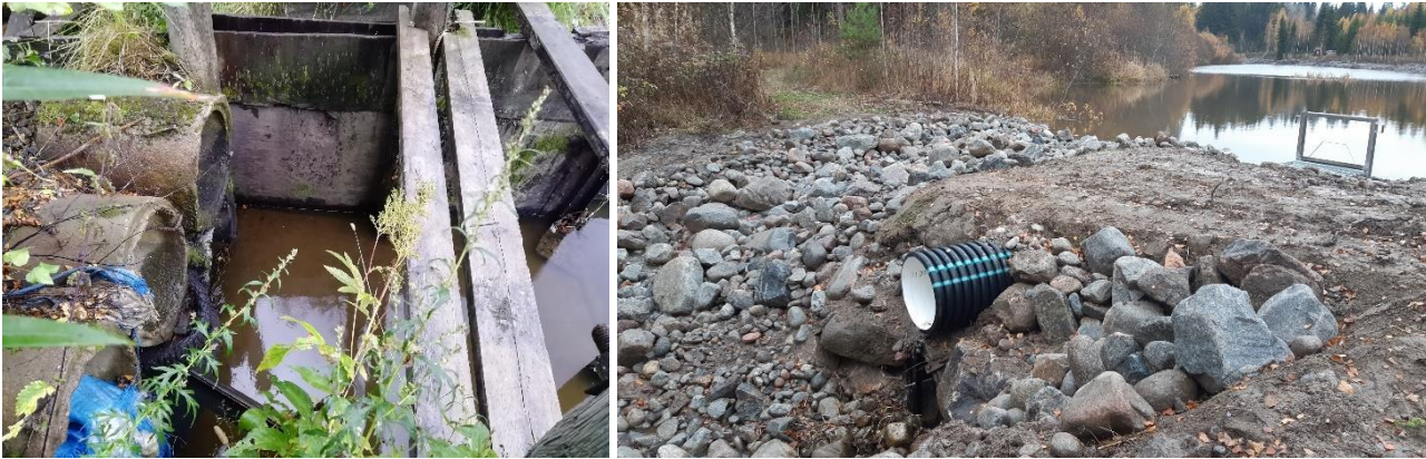
Kuva 21. Vasemmalla huonokuntoisen padon rakenteita ennen purkutöitä ja padon korjausta. Oikealla syksyllä 2022 valmistunut uusi patorakenne, jossa on veden pinnan säätöputki, tyhjennysputki sekä kalan kulun mahdollistava kivetty uoma.
